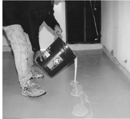
Pour epoxy or urethane next to starting edge
